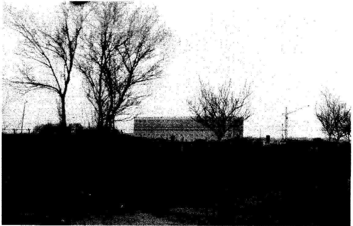
Foto 2 : Bouw van een legeringsflat nabij PRANGENDORF.
